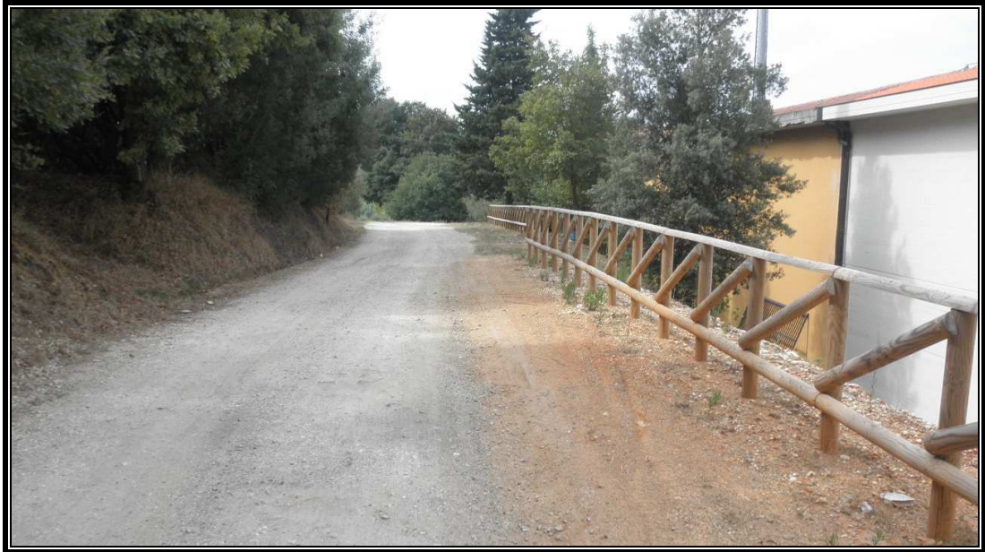
Foto – panoramica dalla “strada” a monte dell’intervento recente
