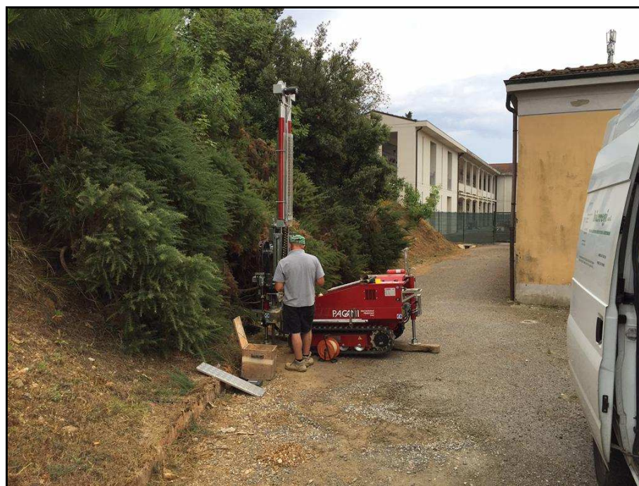
Fig. 7: Prova Penetrometrica Statica (CPT) – PS.1
